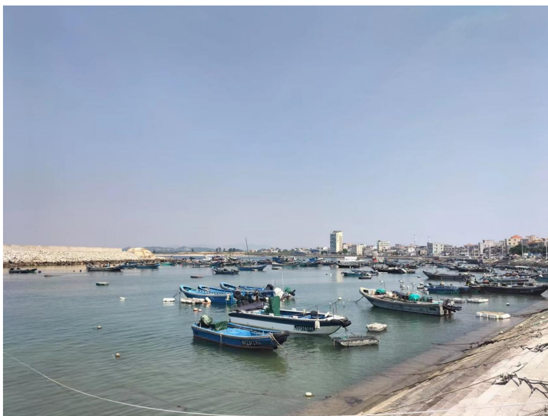
图 5.3.1-2 遮浪渔港一期工程
