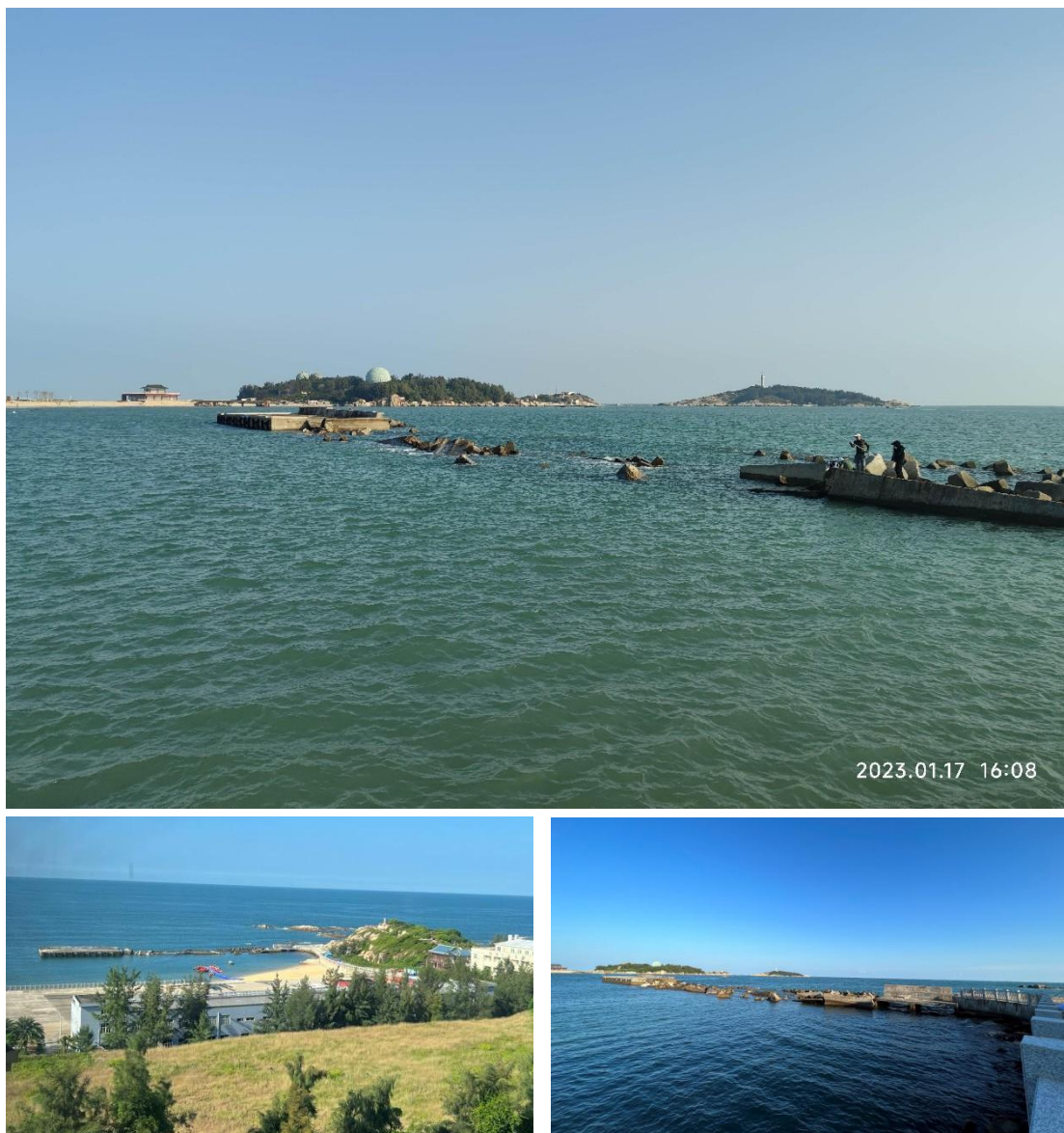
图 3.1.6-2 防波堤现状照片
