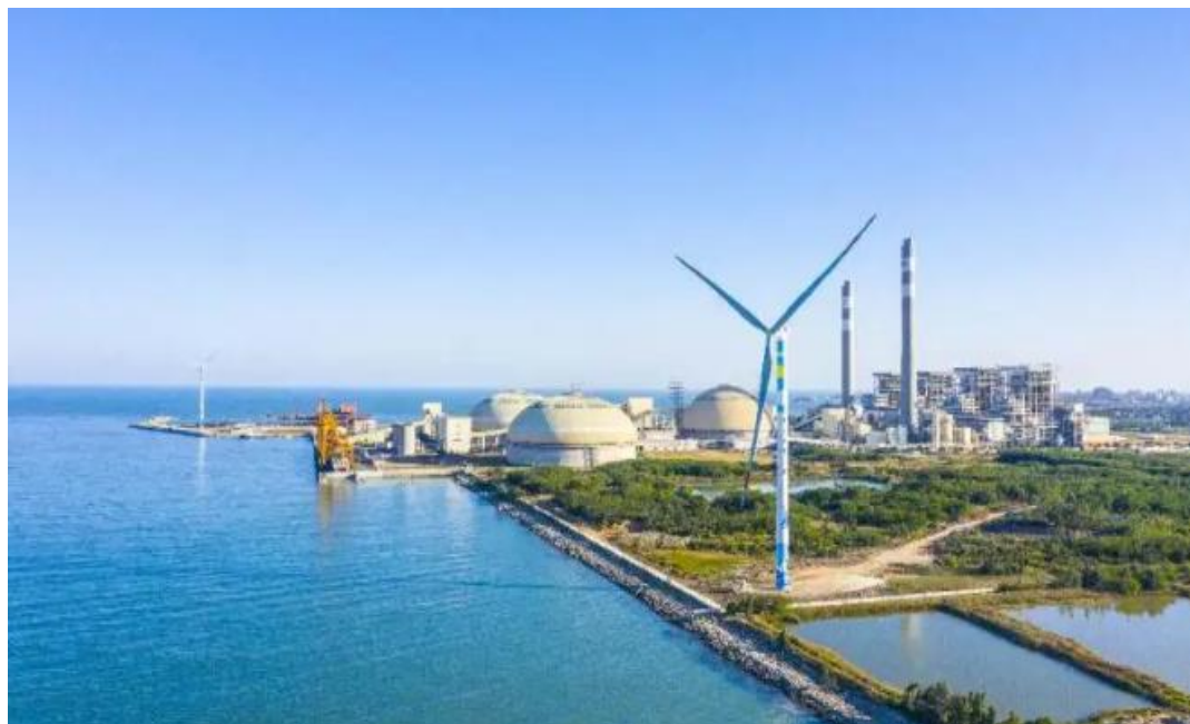
图 5.3.1-3 广东汕尾电厂一期工程
