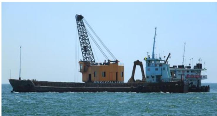
图 3.7-6 抓斗船挖泥施工图
