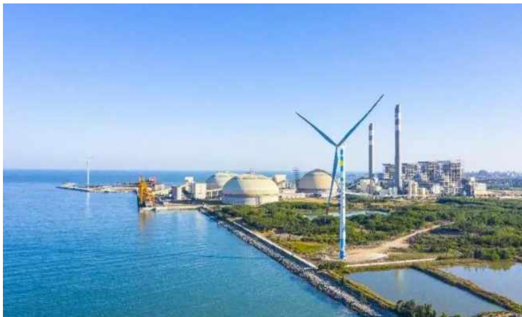
图 6.3.2-4 广东汕尾电厂一期工程
