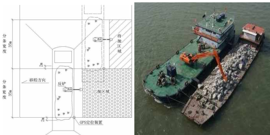
图 4.3.2-11 自航平板驳配反铲抛填平面示意图
