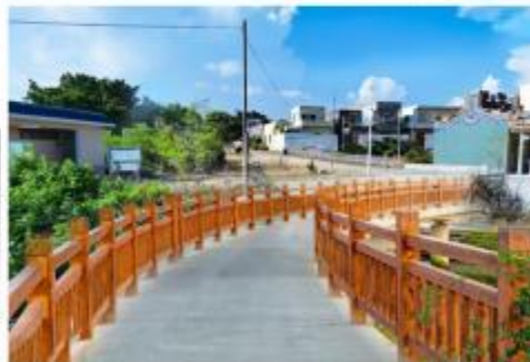
马巷村危桥修缮项目
